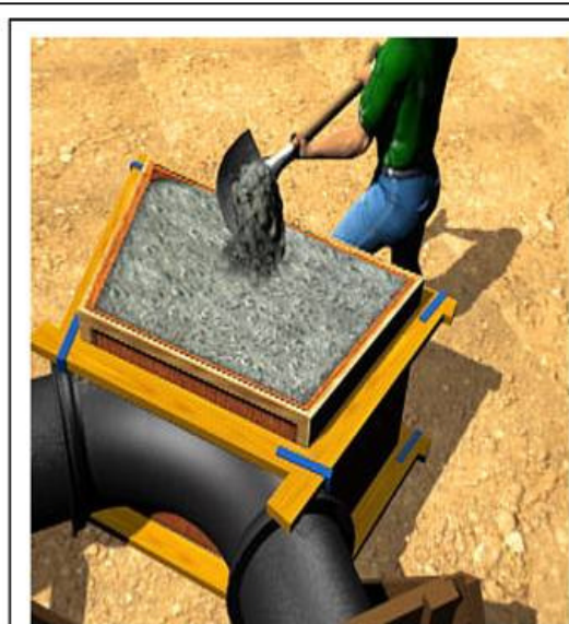
Fig. 04a. Concretagem do bloco
