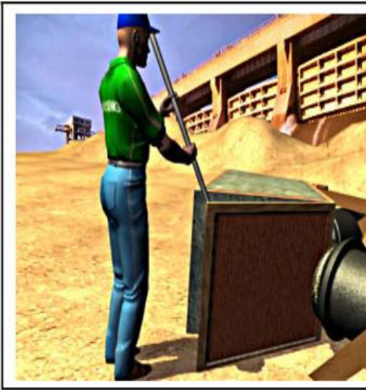
Fig. 05. Desforma do bloco
