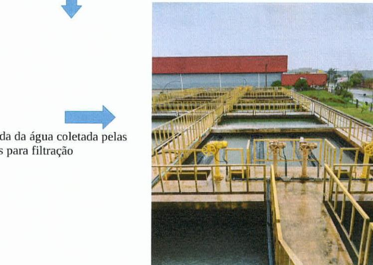
Entrada da água coletada pelas calhas para filtração
