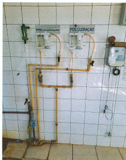
Figura 31: Bombas de dosagem de cloro gás.
