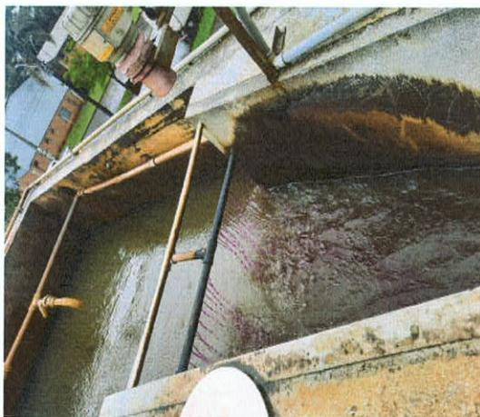
Figura 25: Chegada de água na ETA II , pré-cloração e dosagem de Permanganato de Potássio.
