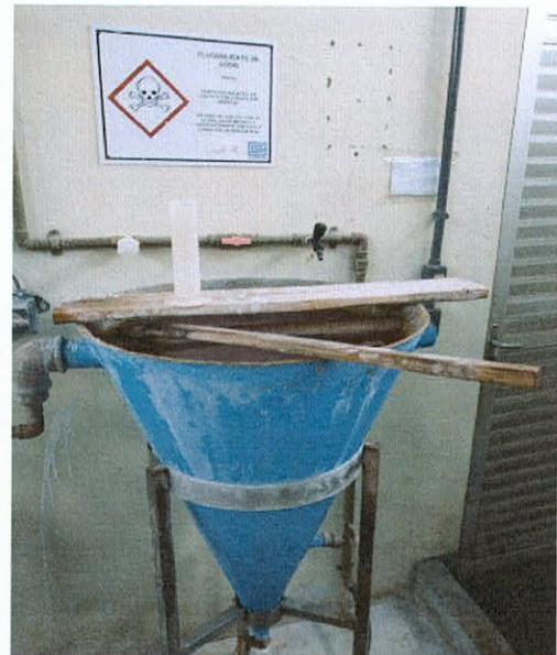
Figura 29: Cone para diluição e dosagem de fluossilicato de sódio.
