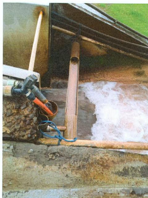
Figura 26: Ponto de adição do coagulante.
