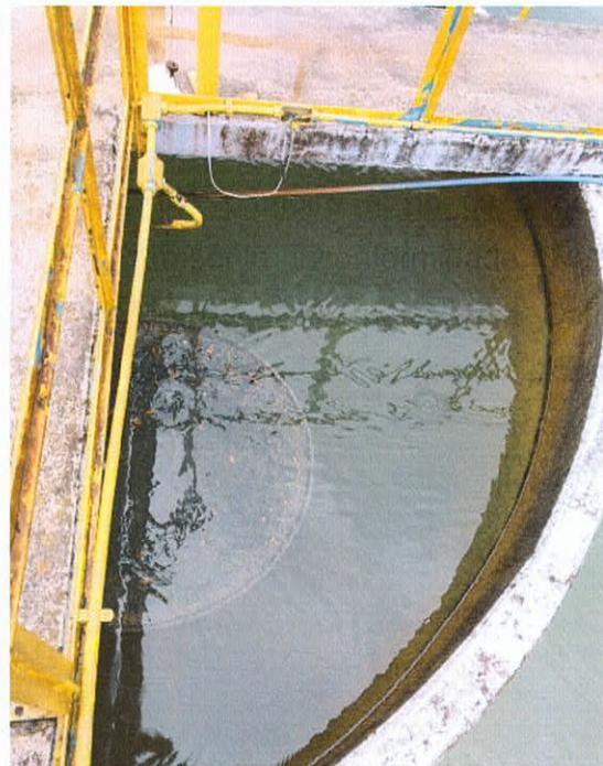
Figura 5: Cone coletor de água decantada.
