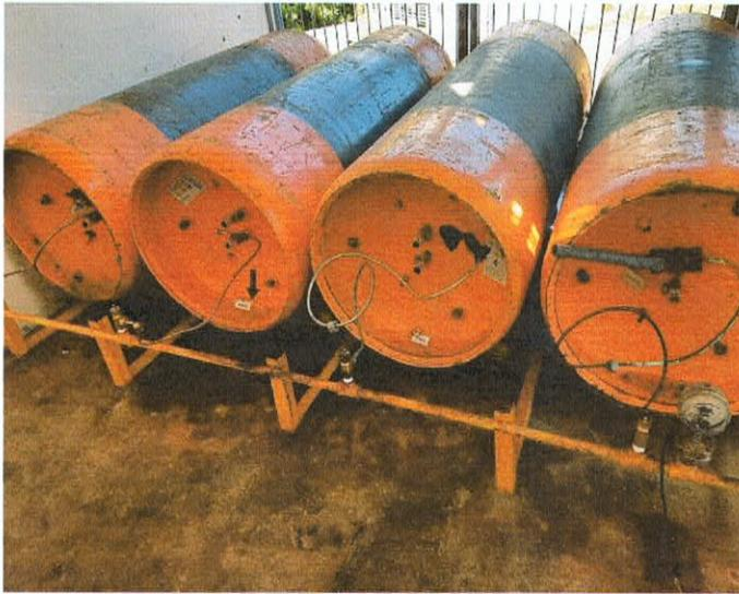
Figura 12: Cilindros de gás cloro
