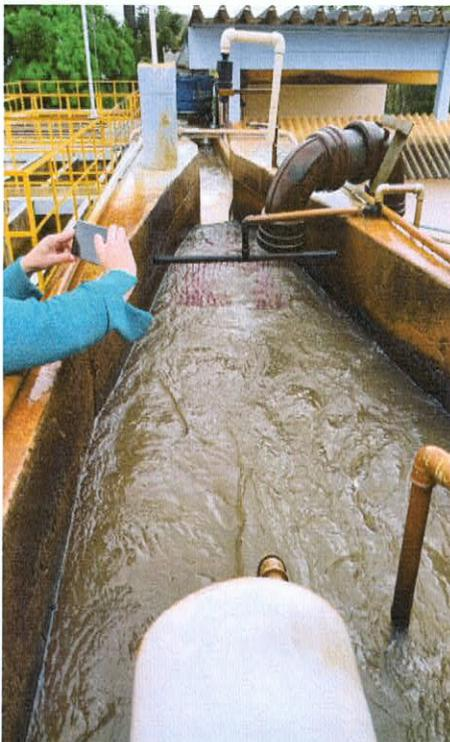
*Figura 1: Adução de água na ETA-1, pré cloração e dosagem de Permanganato de Potássio*
