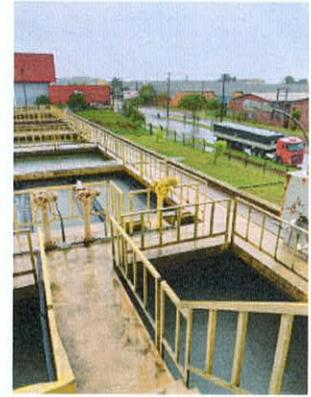
Calha que leva a água com coagulante até os flocculadores.
