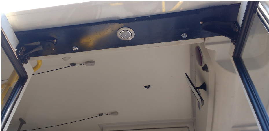
Foto 7 – Luminária do poço de degraus
