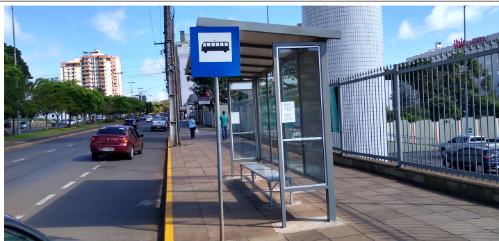
Foto 19 – Placa de identificação e abrigo novo instalado
