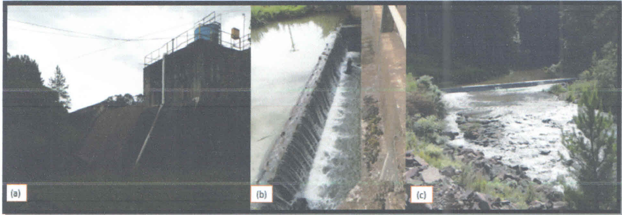
Figura 8 – Imagens do Sistema de adução da barragem do Rio Cravo. a) Vista do TAU I; b) Vista do TAU II; c) Vista da Chaminé de Equilíbrio.
