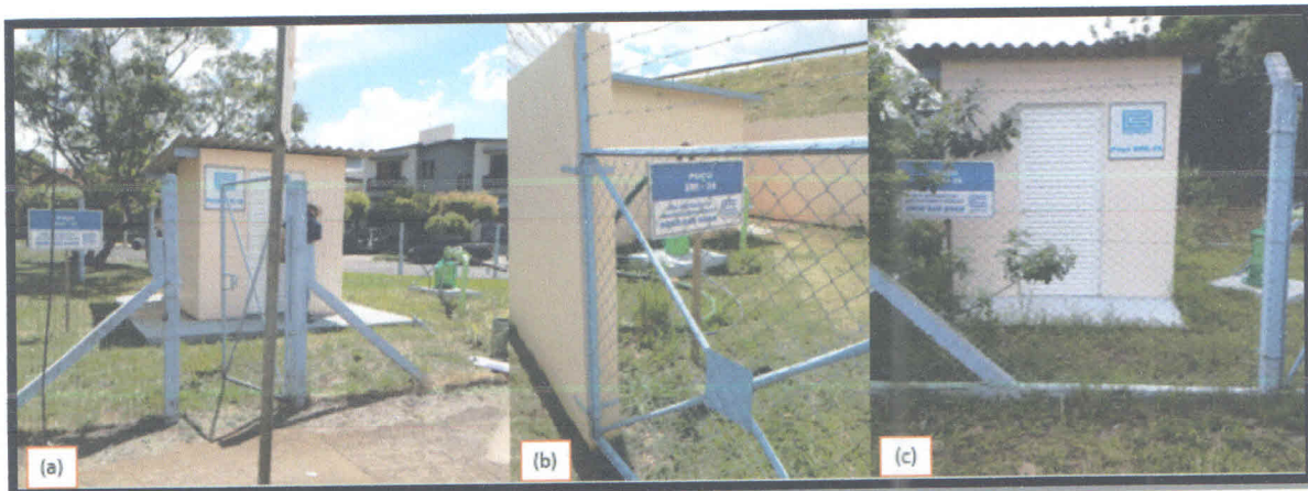
Figura 10 – Vista dos poços de Erechim: a) Poço ERE 016; b) Poço ERE 024; c) Poço ERE 025.
