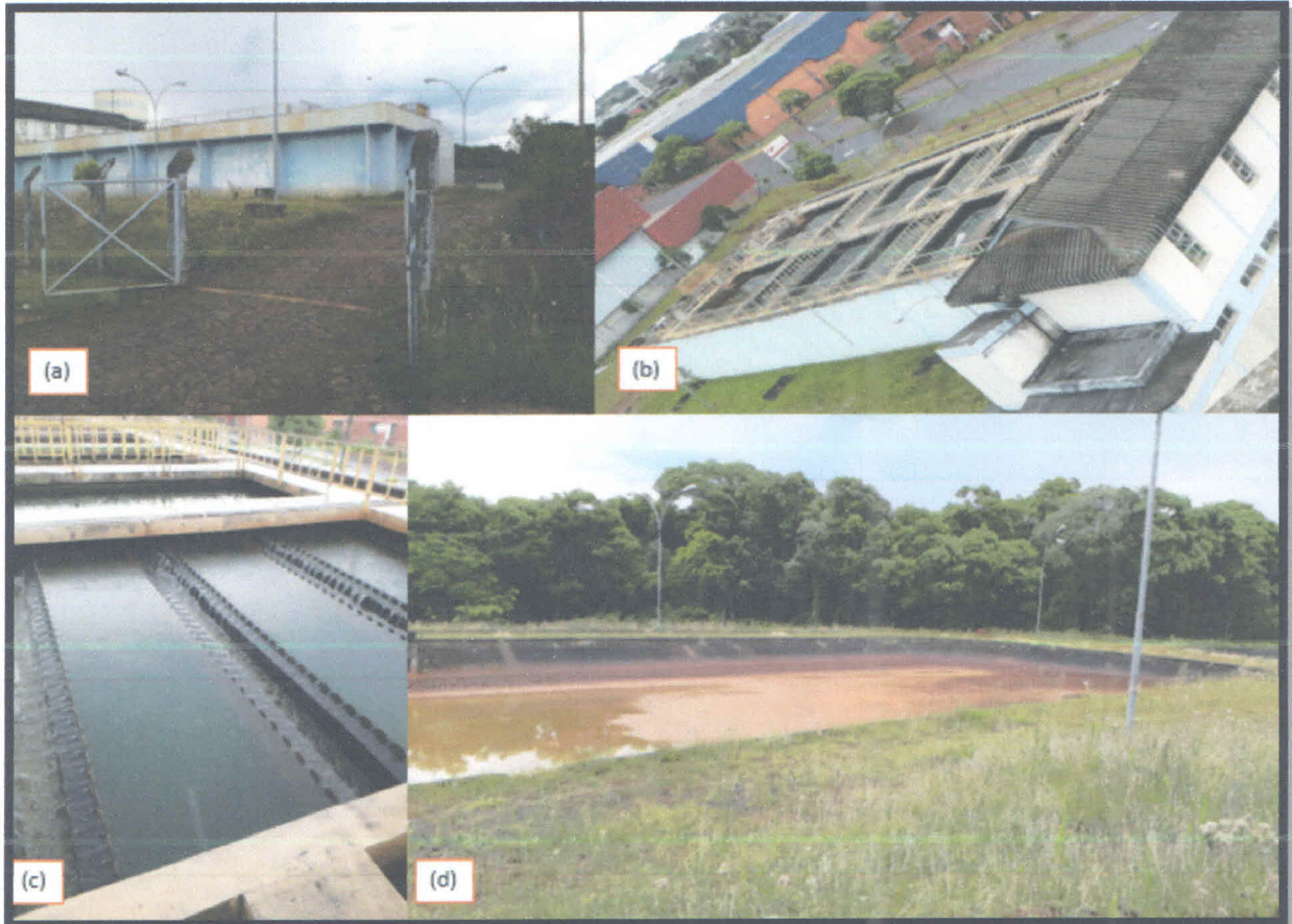
Figura 14: Vistas da ETA II de Erechim. a) Vista da entrada da ETA; b) Vista do Bloco Hidráulico; c) Vista do decantador d) Vista do leito de secagem do lodo.
