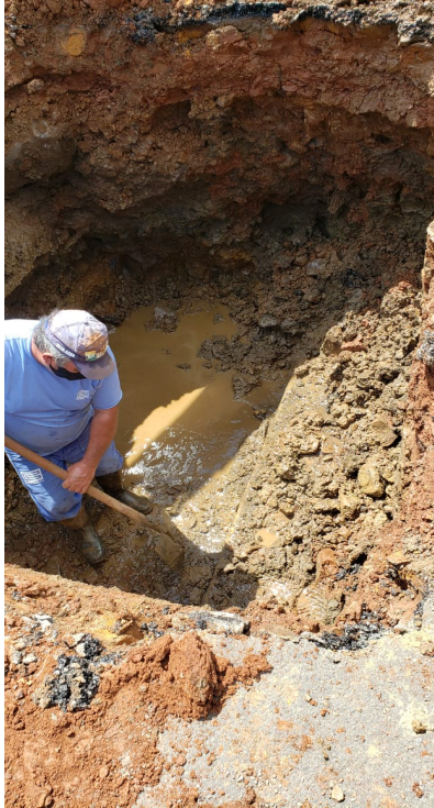
Conserto de vazamento na rede de abastecimento de água.
