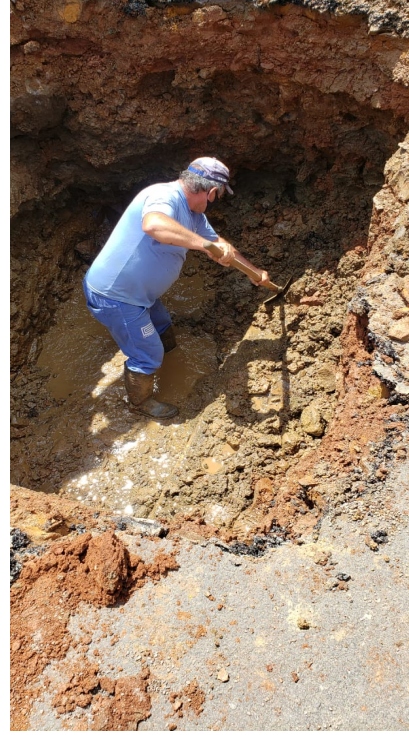
Conserto de vazamento na rede de abastecimento de água.
