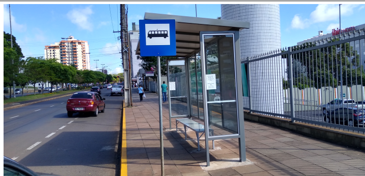
Foto 19 – Placa de identificação e abrigo novo instalado
