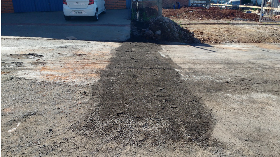
Ligação de ramal efetuado em aproximadamente uma hora, sem a necessidade de interrupção do abastecimento.
