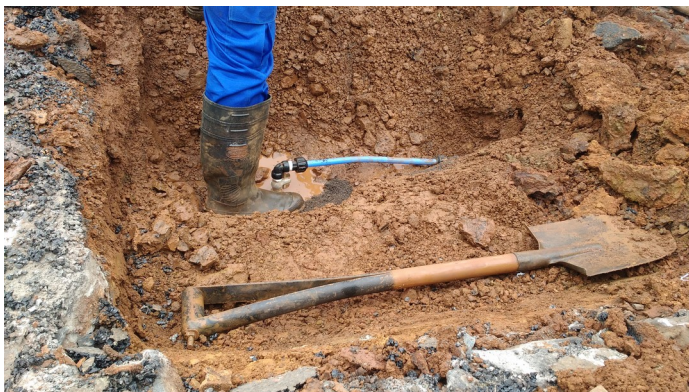
Ligação de ramal efetuado em aproximadamente uma hora, sem a necessidade de interrupção do abastecimento.
