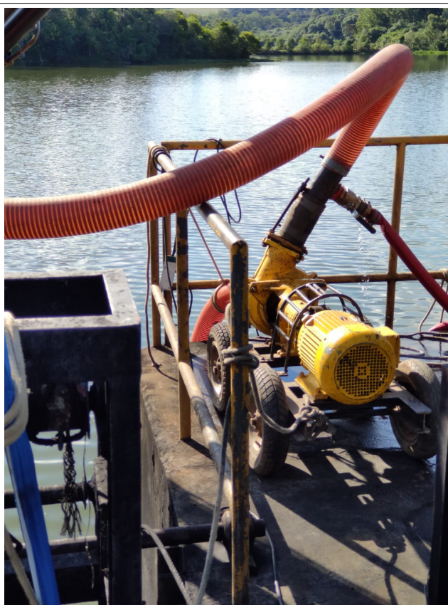
Foto 5 – Equipamento utilizado para retirada do lodo
