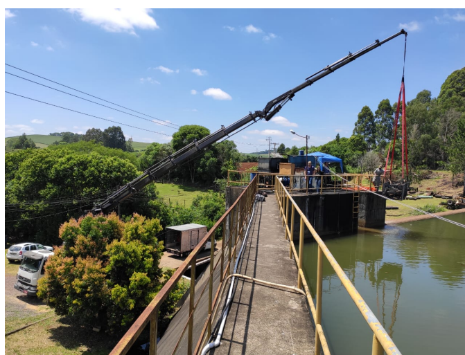
Foto 3 – Guindaste utilizado para retirada da matéria orgânica
