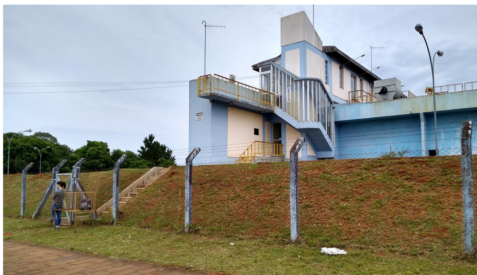
Foto 16 – Área Externa da Estação de Tratamento de Água 2
