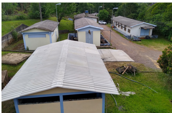
Foto 11 – Pintura da estrutura civil
