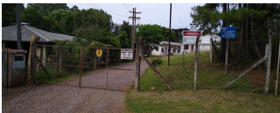
Foto 4 – Portão de Acesso à barragem de captação
