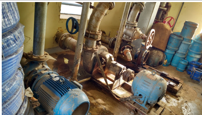
Foto 20 – Vazamentos aparentes
