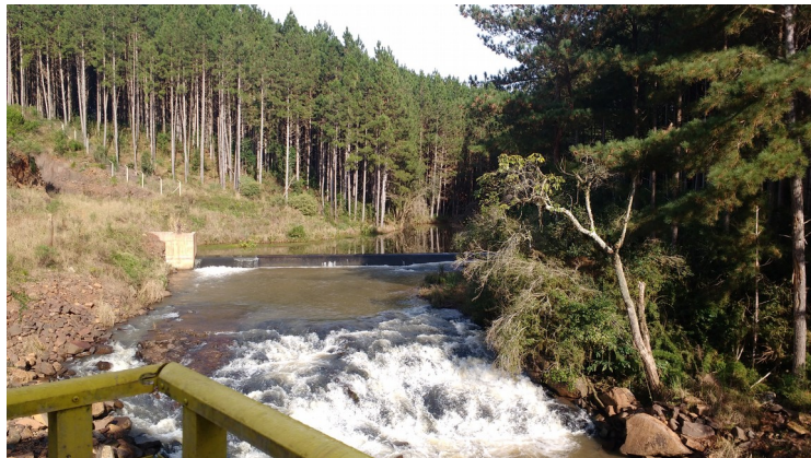
Foto 1 – Barragem de captação
