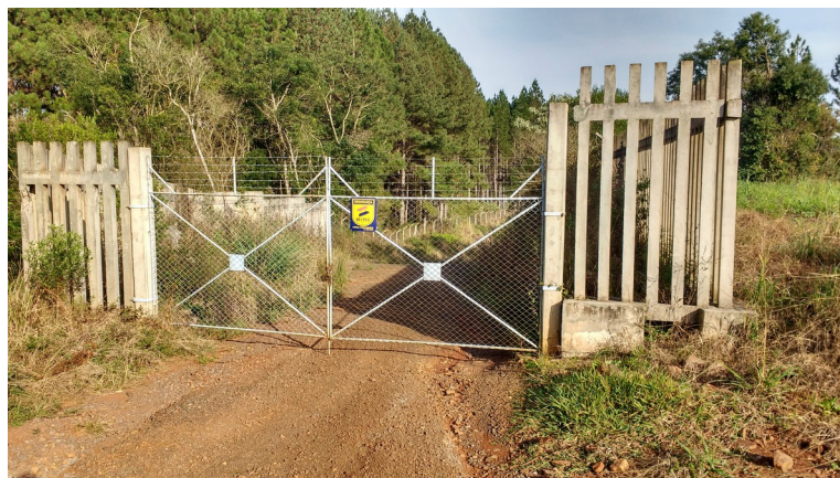
Foto 2 – Acesso à barragem
