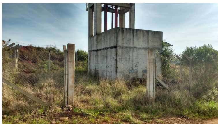
Foto 4 – Acesso à TAU I
