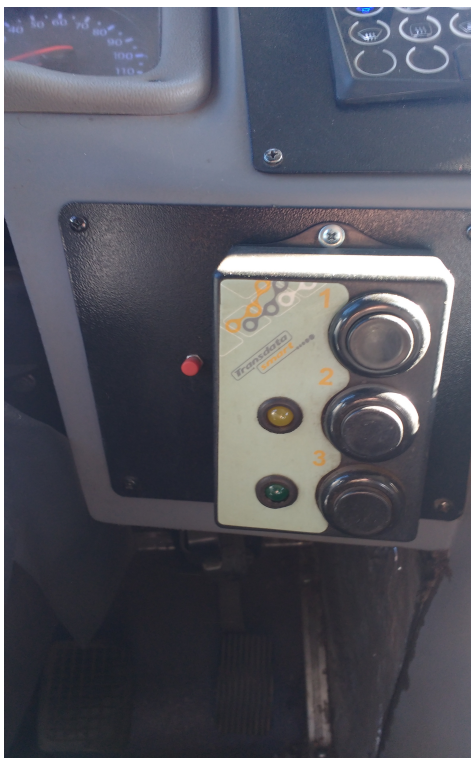
Foto 13 – Botão de emergência
